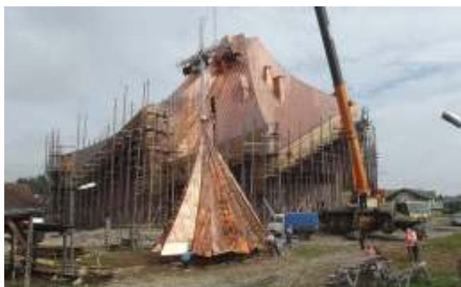
12 sierpnia 2014 Montaż zwieńczenia dachu nowego kościoła
